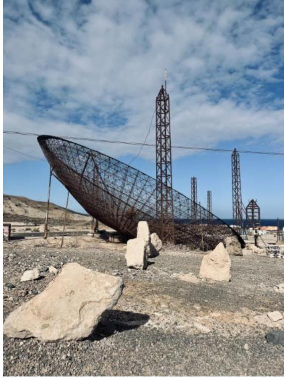
il. 34: Laboratorium energii termoelektrycznej, Teneryfa, Hiszpania (fot. autorki)
