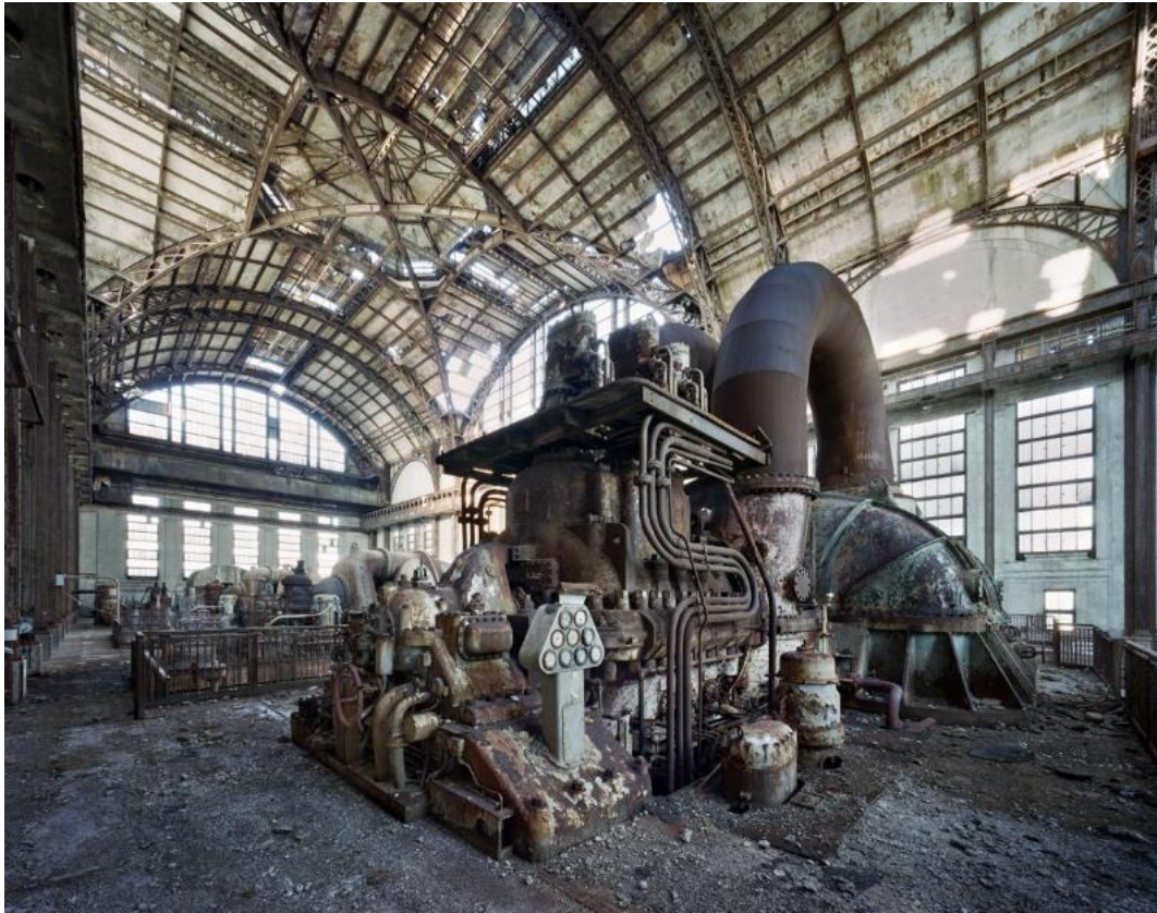
il. 27: Yves Marchand a Romain Meffre, Sala generatorów, elektrownia Port Richmond (2006)
